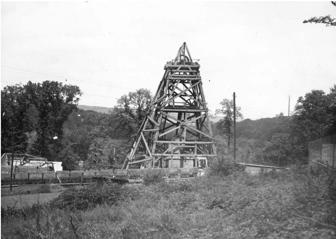
Abb. 19: Teufgerüst des Franziska-Schachtes 2 der Grube Camphausen bei Saarbrücken, errichtet durch die Maschinenfabrik und Unternehmung für bergbauliche Arbeiten Frölich & Klüpfel, undatiert ([montan.dok/BBA 273/12](http://montan.dok/BBA273/12))
