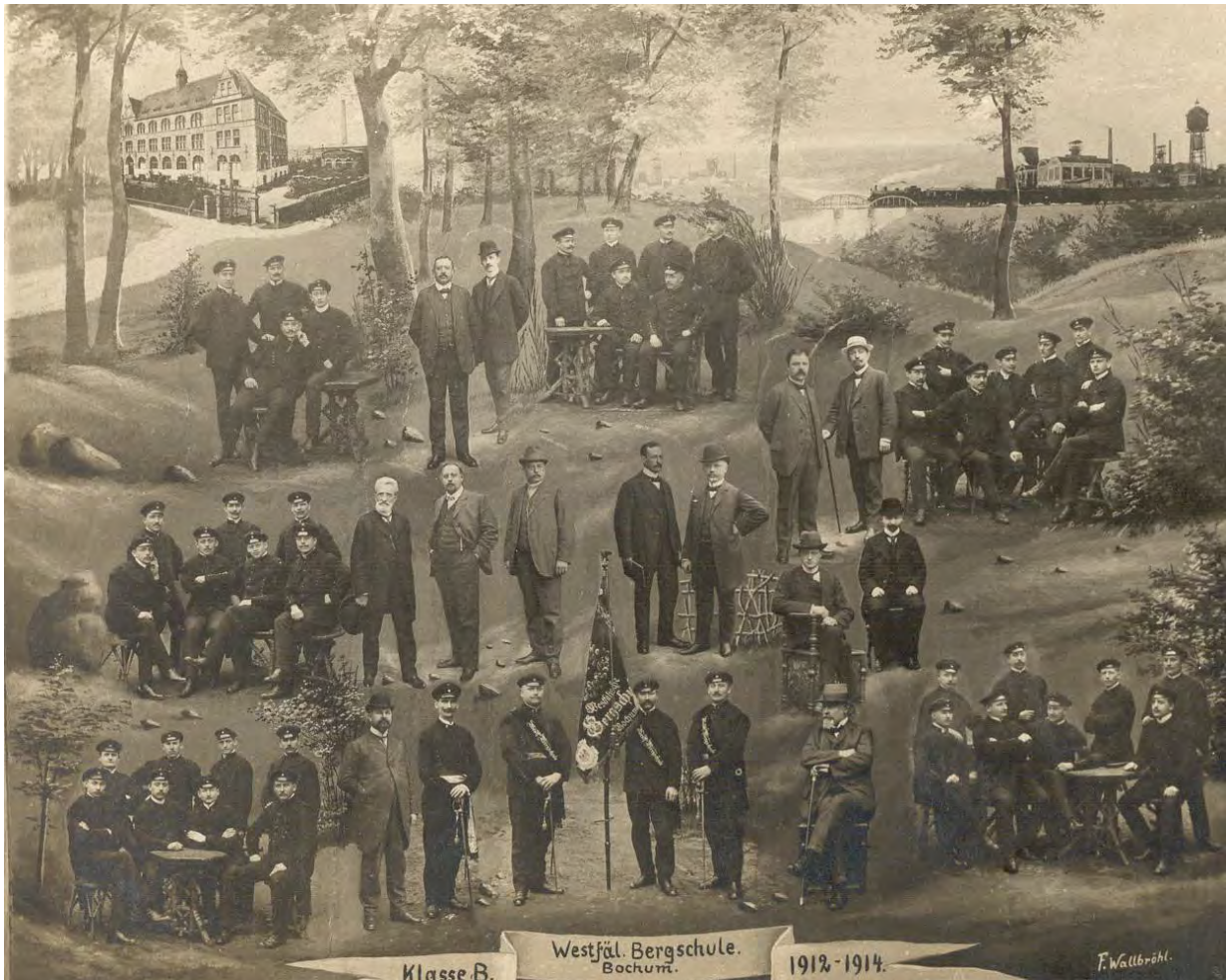
Abb. 7: Abschlussklasse B (1912-)1914 der Bergschule Bochum; montierte Fotografie, im Hintergrund Gebäude der WBK und Silhouette der Stadt (montan.dok/BBA 285/5)
