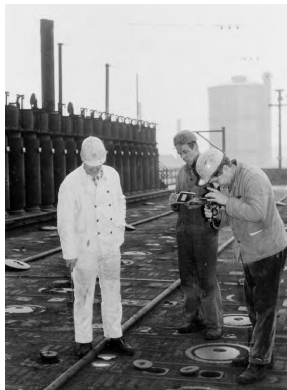
Abb. 35: Messung der Heizzugtemperatur auf der Kokerei Kaiserstuhl, undatiert (Archiv Koßke)
