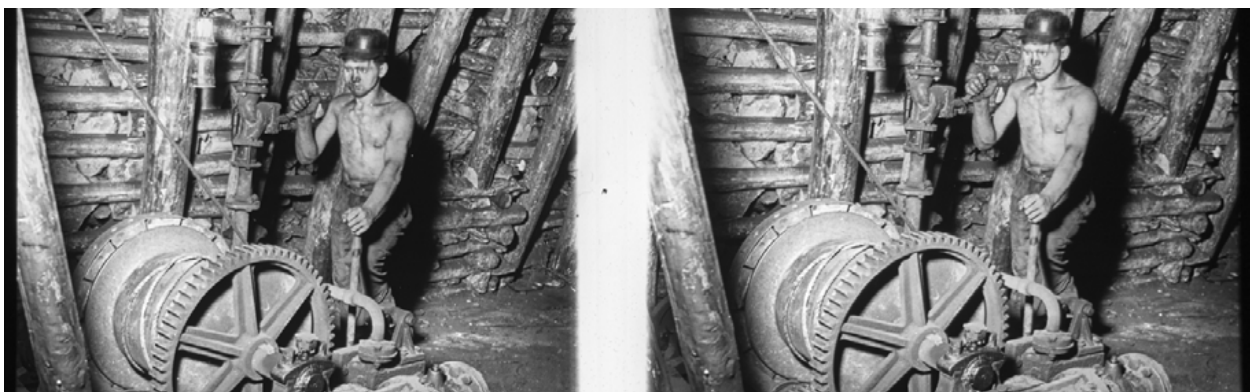
Bergmann an einem Förderhaspel unter Tage. Undatiertes Stereodiam aus den Beständen des montan.dok (Foto: DBM/montan.dok)
