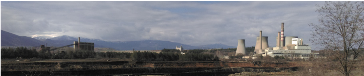
Stillgelegte Einheiten von LIPTOL: Braunkohlenbrikettfabrik (links) und Braunkohlekraftwerk (rechts), Ptolemaida, Griechenland, 13.03.2017 (Foto: Michael Farrenkopf)
