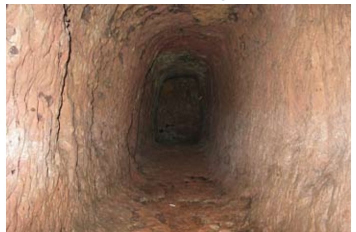
Abb. 7: Unterer Emilianus-Stollen, Blick Richtung Ortsbrust
