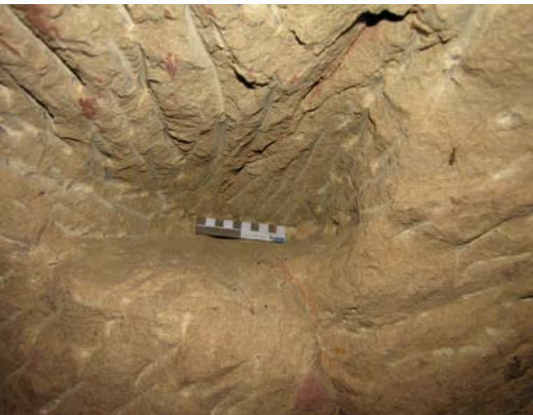
Abb. 10: Stollen Bruss, eine der Taschen, vermutlich als Widerlager genutzt
