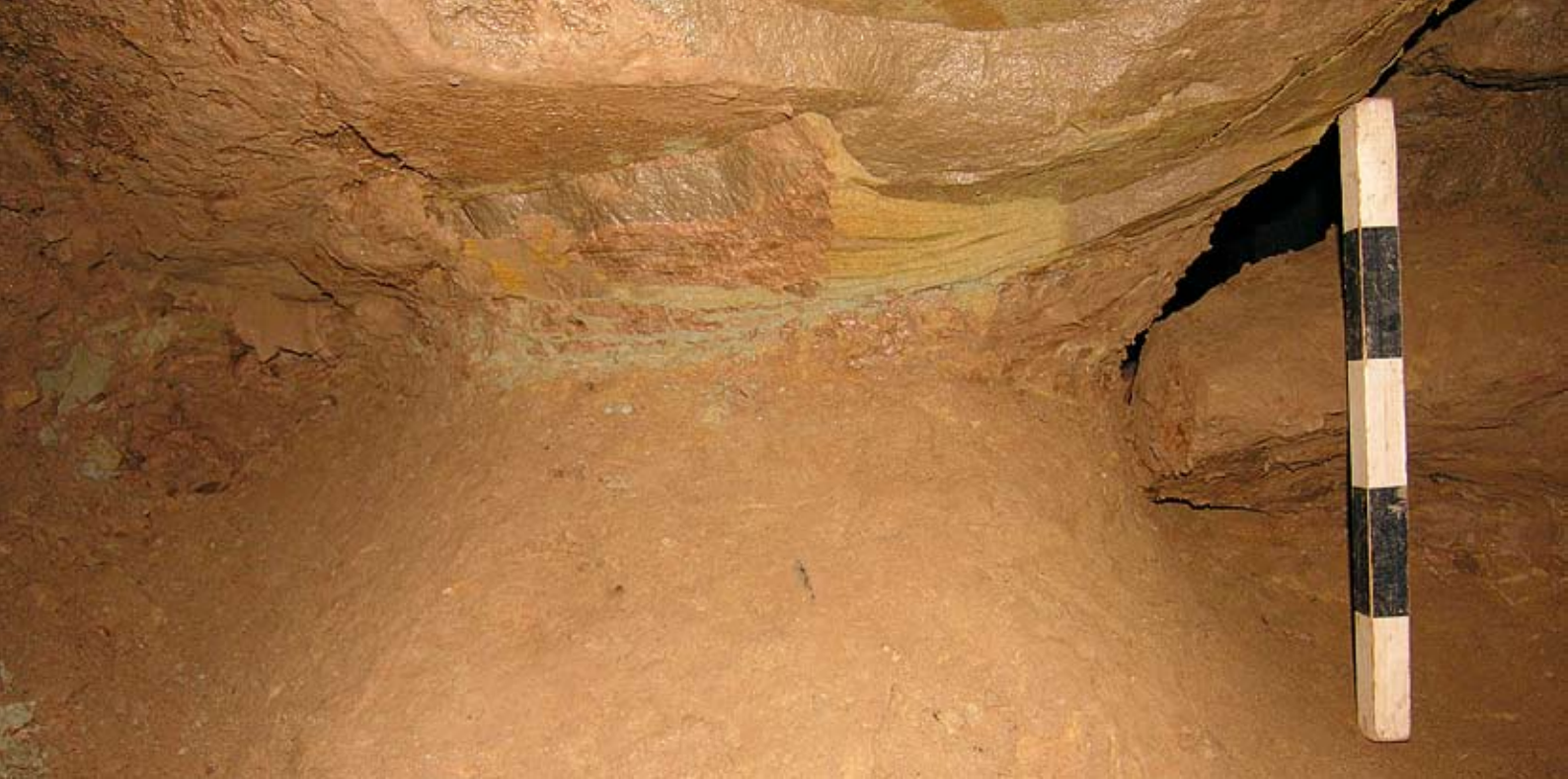
Abb. 18: Stollen Bruss, eine der Bergfesten. In der Mitte ist noch ein schmaler Rest der grauen Lettenschicht erhalten, in der die Azuritkonkretionen eingelagert waren
