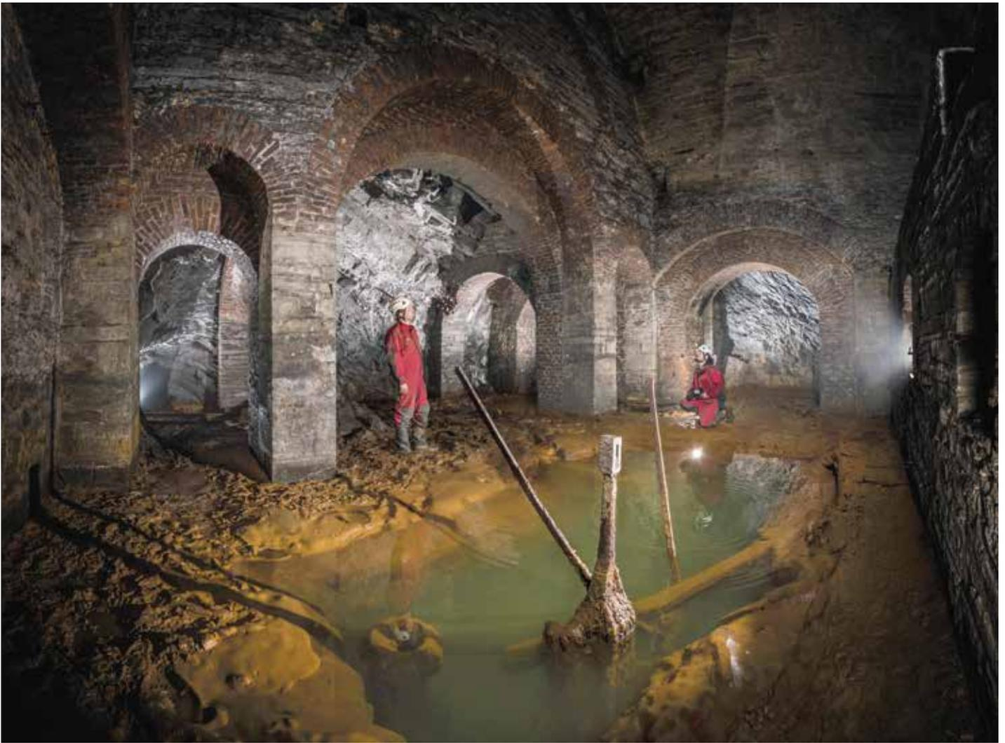
Abb. 14: Grube Landeskrone. Blick von der Mauer der Dampfmaschinenplattform (rechts randlich noch im Ansatz zu erkennen) in die Schachthalle mit abgeoffenem Schacht (im Vordergrund), aus dem Teile des Pumpengestänges ragen. (© Foto: Deutsches Bergbau-Museum Bochum/P. Thomas)
