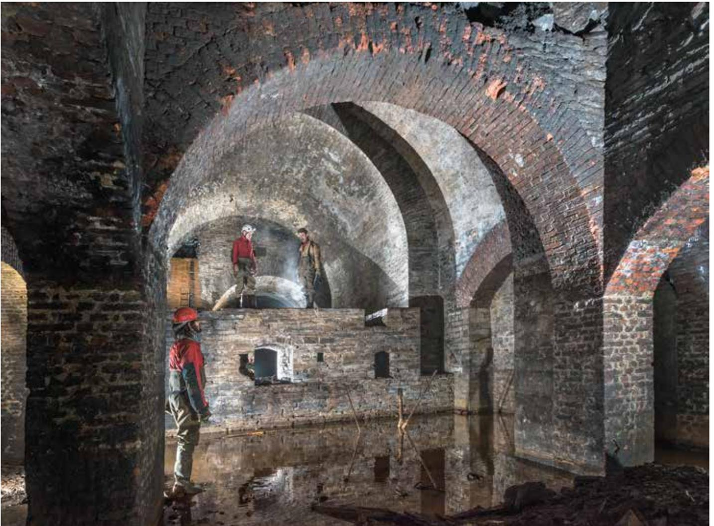
Abb. 12: Grube Landeskron. Blick durch die Schachthalle auf die Dampfmaschinenplattform in der Bildmitte. Im Hintergrund (erleuchtet) ist das Tonnengewölbe der Kesselhalle erkennbar. (© Foto: Deutsches Bergbau-Museum/P. Thomas)
