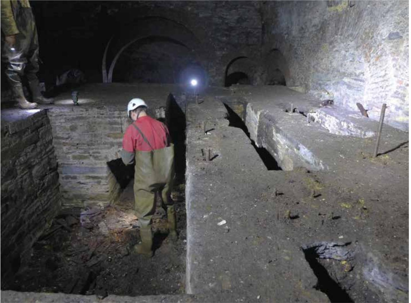
Abb. 13: Grube Landeskron, Dampfmaschinenplattform (Blickrichtung Schachthalle). Am linken Bildrand befindet sich die Aussparung der Seiltrommel, rechts solche des Schwungrades und der Dampfmaschine, z. T. mit herausragenden eisernen Fundamentschrauben. (© Foto: Deutsches Bergbaumuseum/P. Thomas)
