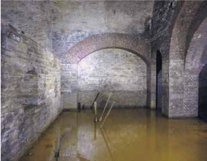
Abb. 16: Grube Landeskrone, Schachthalle (Dampfmaschinenpodest am linken Bildrand, Blindschachtöffnung mit herausragenden Kunstgestänge im Vordergrund). Blick auf den flachen und ausgemauerten Stützbogen. (© Foto: Deutsches Bergbau-Museum Bochum/P. Thomas)
