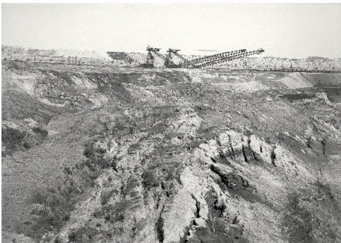
Abb. 26: Paul Schulz: Braunkohleabbau, Tagebau Hirschfelde (Kopalnia Turaszów), mit Rutschung am 18.6.1925. Blick nach Nordwesten auf Abraumbsetzer, 1925. (© SLUB/Deutsche Fotothek, http://www.deutschefotothek.de/documents/obj/70003826 )
