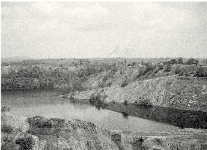
Abb. 30: Paul Schulz: Braunkohlentagebau Olbersdorf. Zustand nach zweijähriger Stilllegung (abgesoffen), in Bildmitte die ehemalige schräge Förderrampe, 1939. (© SLUB/Deutsche Fotothek, http://www.deutschefotothek.de/documents/obj/90036816 )
