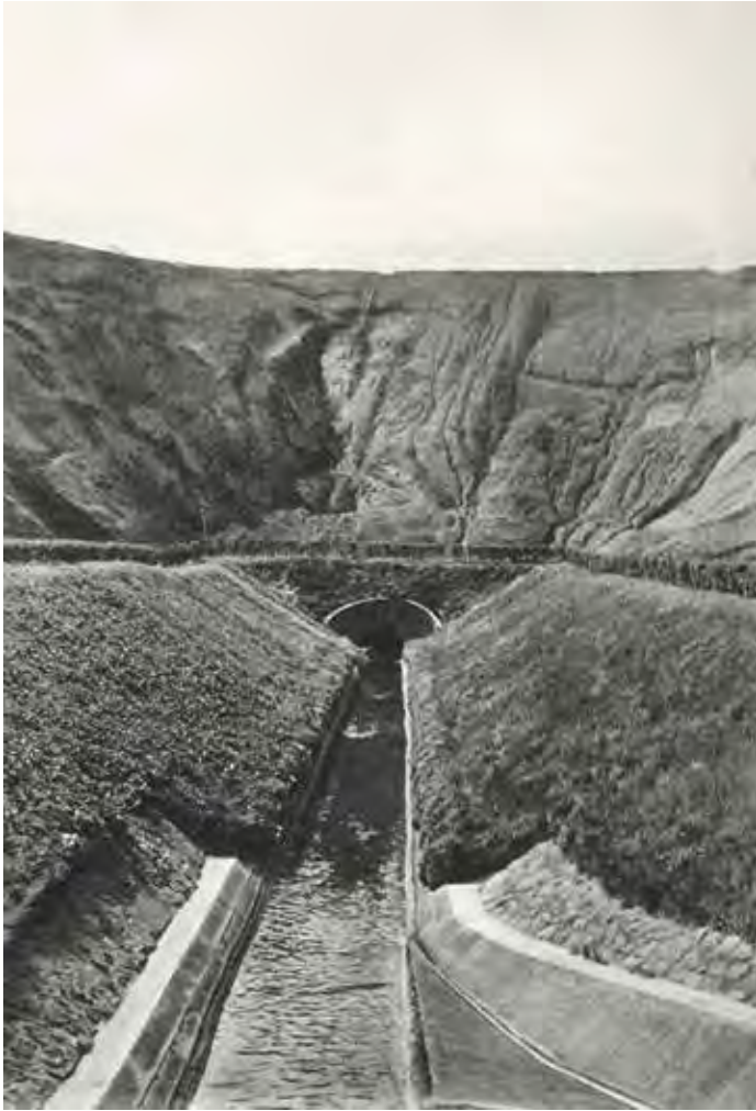
Abb. 10: O. A.: Zeichenhalde mit unterführtem Wasserlauf, in: Block, Max Paul (Hg.): Der Gigant an der Ruhr , Berlin 1928, S. 143.
