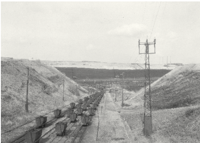
Abb. 25: Paul Schulz: Braunkohlengrube bei Lützkendorf (südwestlich Merseburg). Doppelkettenbahn, vor 1945. (© SLUB/Deutsche Fotothek, http://www.deutschefotothek.de/documents/obj/72002972 )
