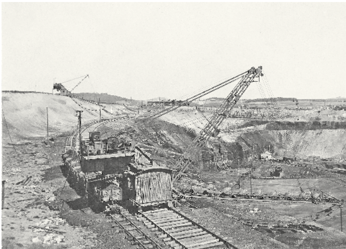
Abb. 24: Ernst Gäbler: Braunkohle, Olbersdorf, Tagebau, Eimerkettenbagger, Schurrenabbau, 1920/1925. (© SLUB/Deutsche Fotothek, http://www.deutschefotothek.de/documents/obj/70062342 )
