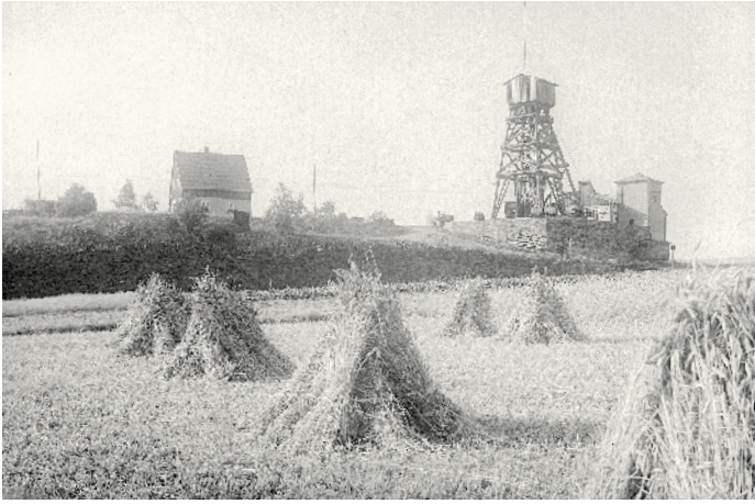
Abb. 19: Karl August Reymann: Beihilfer Ferdinand-Schacht, Rothefurth, erbaut 1937, 1937. (© Stadt- und Bergbaumuseum Freiberg/Fotothek, 1414 Glasnegativ)
