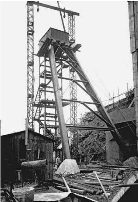
Abb. 4: Baustelle der Erzaufbereitungsanlage: Aufstellen des vormontierten Fördergerüsts über dem Rammelsbergsschacht, 1937. (© Foto: Sammlung Weltkulturerbe Rammelsberg)
