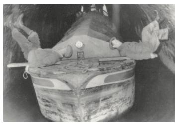
Abb. 3: Die Methode des "legging" durch die Bootsbesatzung. (Postkarte undatiert, Sammlung Rainer Slotta)
