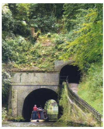
Abb. 4: Der Shrewley-Schiffstunnel des Grand Union Canal (1799) mit dem höher gelegenen Tunnel für die Treidelpferde. (© Foto: Rainer Slotta)
