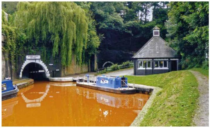
$Abb.\ 1:\ Die\ beiden\ Harecastle-Schiffstunnel\ des\ Trent-and-Mersey-Canal:\ rechts\ das\ Mundloch\ des\ \"{a}lteren,\ von\ James\ Brindley\ erbauten\ Schiffstunnels\ (1770-1777),\ links\ das\ des\ j\"{u}ngeren,\ noch\ heute\ genutzten,\ von\ Thomas\ Telford\ aufgefahrenen\ Schiffstunnels\ (1825-1827).\ (@\ Foto:\ Rainer\ Slotta)$
