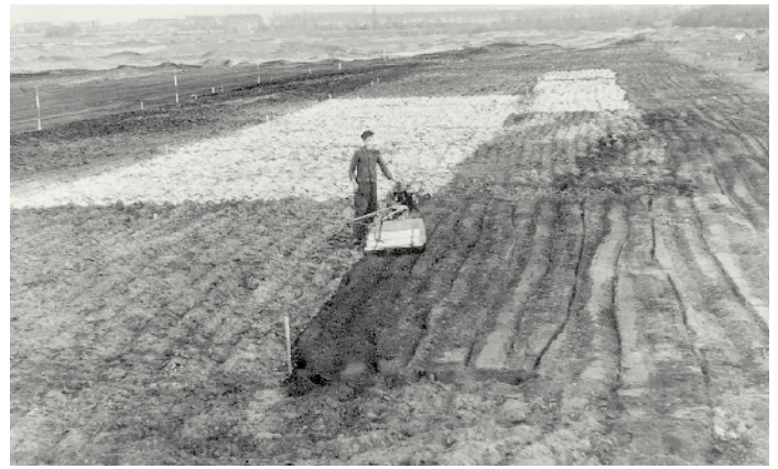
Abb. 7: Bodenneutralisation mit Branntkalk auf einer Versuchsfläche im Tagebau Böhlen. (© Sächsisches Staatsarchiv Leipzig, 20687 VEB „Otto Grotewohl“ Böhlen, Akte 1193)
