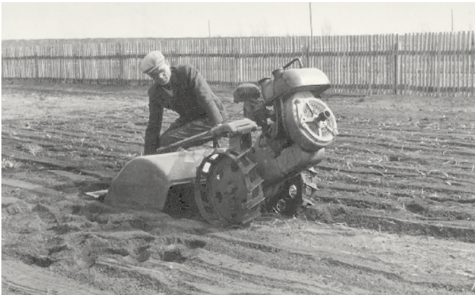
Abb. 5 und 6: Neben den Verfahren gehörte auch die Entwicklung von Spezialgeräten zur Bodenaufbereitung zu den Forschungsaufgaben (oben Anwalzen des Bodens, unten Bodenfräse beim meliorieren). (© Sächsisches Staatsarchiv Leipzig; 20687 VEB „Otto Grotewohl“ Böhlen, Akte 1193)
