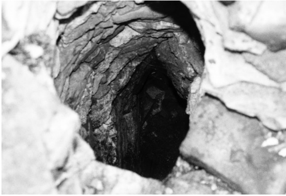
Abb. 9: Blick hinunter in den Schacht von LR 5.
